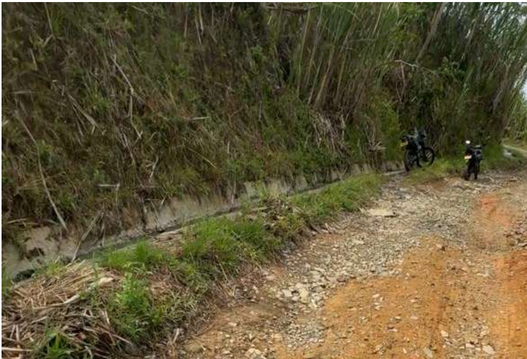
Fotografía 4 Cuneta aguas arriba de la obra transversal existente, recoge toda la escorrentía superficial del talud y la conduce hacia la alcantarilla aguas arriba de la obra transversal existente.
