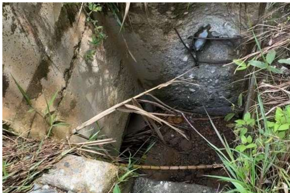
Fotografía 2 Alcantarilla aguas arriba de la obra transversal existente, se observa deterioro y exposición del acero y entrada de la tubería en fibra de vidrio de 36"
