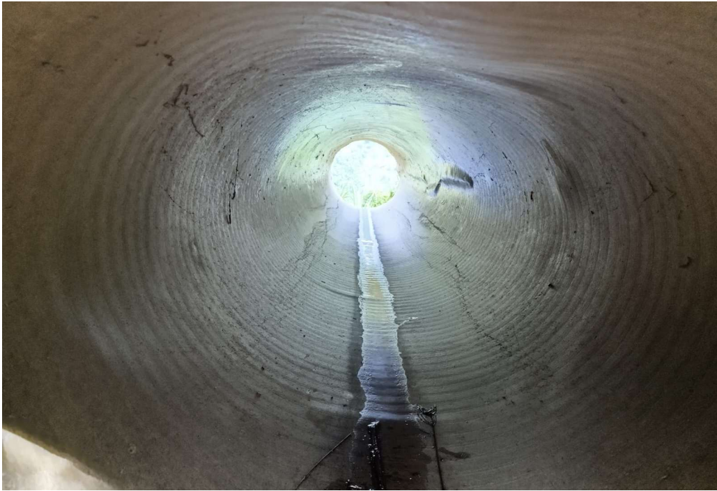
Fotografía 3 Alcantarilla en Tubería PVC de 36" de la obra transversal existente con presencia de abolladuras o aplastamiento.
